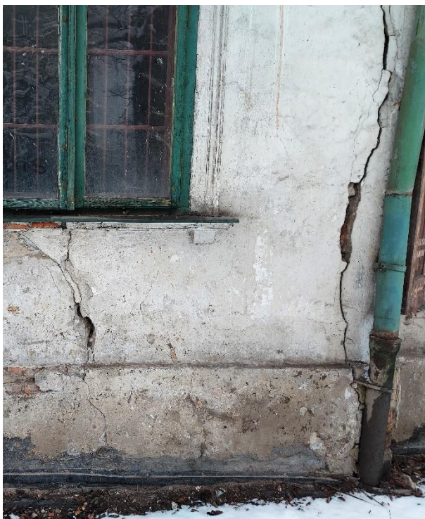
Fot. 3, 4. Budynek „Kossakówka, Pl. Kossaka 4, Kraków. Widok fragmentu elewacji południowej. Bardzo zły stan murów i tynków, widoczne ubytki tynku w partiach przyziemnych i zawilgocenie. Głębokie pęknięcia konstrukcyjne pod oknem i w narożniku budynku, po prawej widok po wykonaniu zszyć. Fot. D. Narowska Avonza, luty 2021 r.
