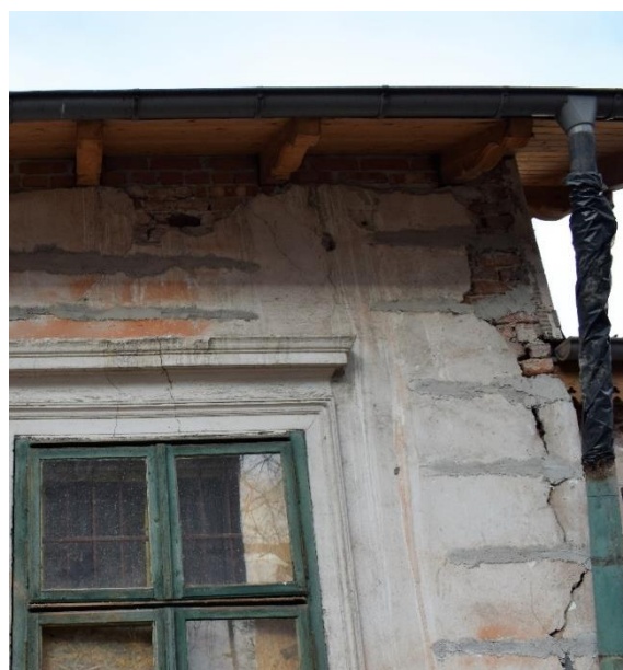
Fot. 5, 6. Budynek „Kossakówka, Pl. Kossaka 4, Kraków. Widok fragmentu elewacji południowej. Bardzo zły stan murów i tynków, widoczne ubytki tynku. Głębokie pęknięcia w narożniku budynku. Po prawej widoczne zszyca murów, wykonane 2021. Fot. D. Narowska Avonza, luty 2021 r.
