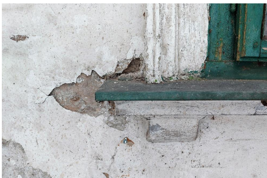
Fot. 9, 10, 11. Budynek „Kossakówka, Pl. Kossaka 4, Kraków. Widok fragmentów elewacji południowej. Bardzo zły stan murów i tynków, spowodowany przez wilgoć, wysolenia oraz dużą ilość nawarstwień. Fot. D. Narowska Avonza, luty 2021 r
