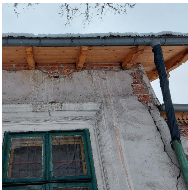
Fot. 5, 6. Budynek „Kossakówka, Pl. Kossaka 4, Kraków. Widok fragmentu elewacji południowej. Bardzo zły stan murów i tynków, widoczne ubytki tynku. Głębokie pęknięcia w narożniku budynku. Po prawej widoczne zszyca murów, wykonane 2021. Fot. D. Narowska Avonza, luty 2021 r.
