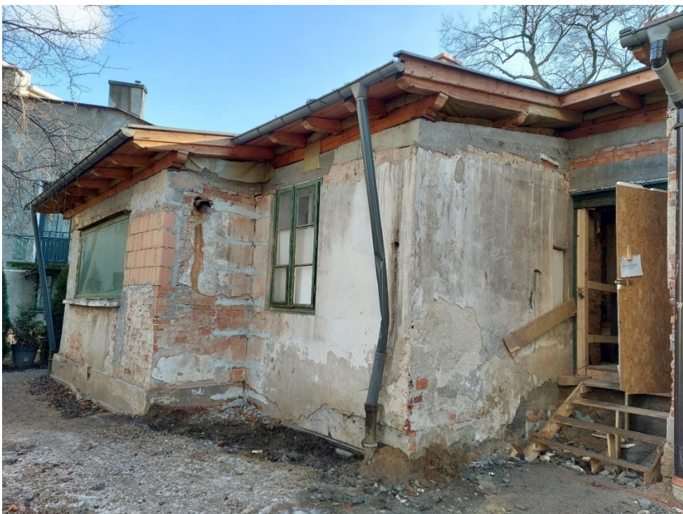
Fot. 1. Budynek „Kossakówka, Pl. Kossaka 4, Kraków. Widok fragmentu elewacji północnej. Bardzo zły stan murów i tynków, widoczne nowe przemurowania wykonane z pustaków ceramicznych i mocnej zaprawy cementowej. Fot. D. Narowska Avonza, luty 2021 r.
