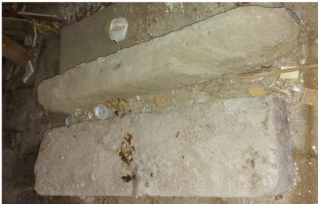
Fot. 16 Budynek „Kossakówka, Pl. Kossaka 4, Kraków . Widoczne zdemontowane stopnie z piaskowca w bardzo złym stanie. Fot. D. Narowska Avonza
