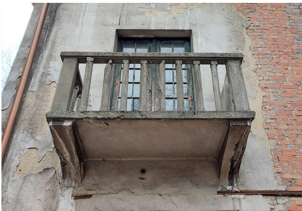
Fot. 16. Budynek „Kossakówka, Pl. Kossaka 4, Kraków. Żelbetowy balkon na elewacji zachodniej, bardzo zły stan wsporników i płyty, umiarkowania zły stan pochwytem i tralek. Widoczne fragmenty odsłoniętego zbrojenia, zacieki i spękania. Fot. D. Narowska Avonza
