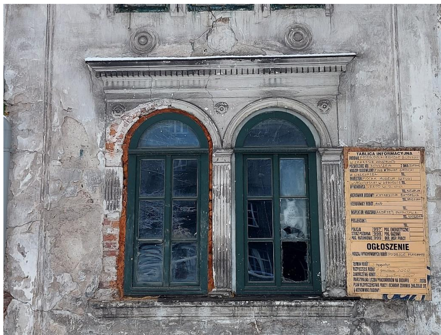
Fot. 13. Fragment środkowej części elewacji południowej. Budynek „Kossakówka, Pl. Kossaka 4, Kraków Ubytki dekoracji architektonicznej, brak środkowej rozetki wraz z otaczającym ją tynkiem, rozległe ubytki obramienia biforium. Bardzo zły stan murów i tynków, spowodowany przez wilgoć, wysolenia oraz mikroorganizmy i glony. Fot. D. Narowska Avonza, luty 2021 r.
