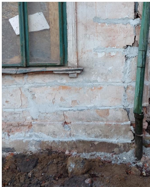
Fot. 3, 4. Budynek „Kossakówka, Pl. Kossaka 4, Kraków. Widok fragmentu elewacji południowej. Bardzo zły stan murów i tynków, widoczne ubytki tynku w partiach przyziemnych i zawilgocenie. Głębokie pęknięcia konstrukcyjne pod oknem i w narożniku budynku, po prawej widok po wykonaniu zszyć. Fot. D. Narowska Avonza, luty 2021 r.
