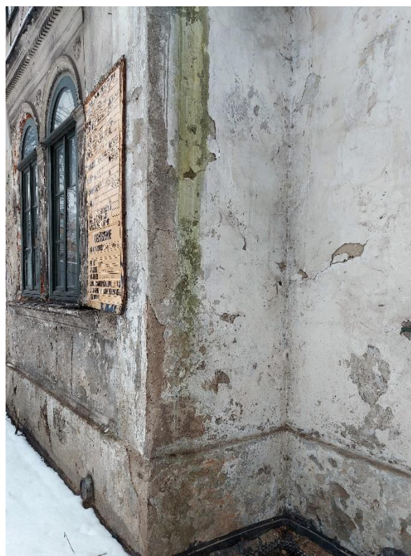
Fot. 7, 8. Budynek „Kossakówka, Pl. Kossaka 4, Kraków. Widok fragmentów elewacji południowej. Bardzo zły stan murów i tynków, spowodowany przez wilgoć, wysolenia oraz mikroorganizmy i glony. Fot. D. Narowska Avonza, luty 2021 r.
