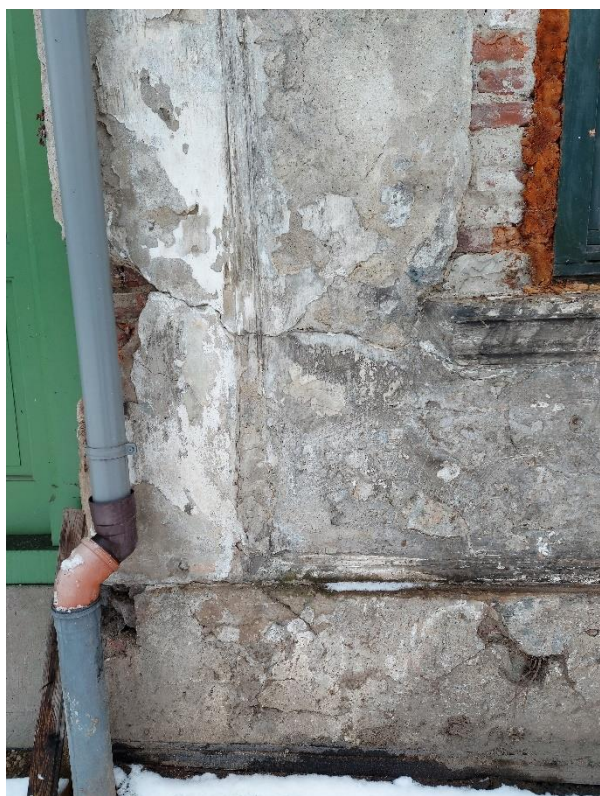
Fot. 7, 8. Budynek „Kossakówka, Pl. Kossaka 4, Kraków. Widok fragmentów elewacji południowej. Bardzo zły stan murów i tynków, spowodowany przez wilgoć, wysolenia oraz mikroorganizmy i glony. Fot. D. Narowska Avonza, luty 2021 r.
